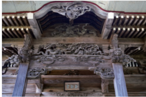
⑤-1 岡の諏訪神社 Suwa Shrine at Oka 津南町指定文化財の江戸時代に彫られた、熊谷源太郎によるみごとな宮彫りを見ることができます。
